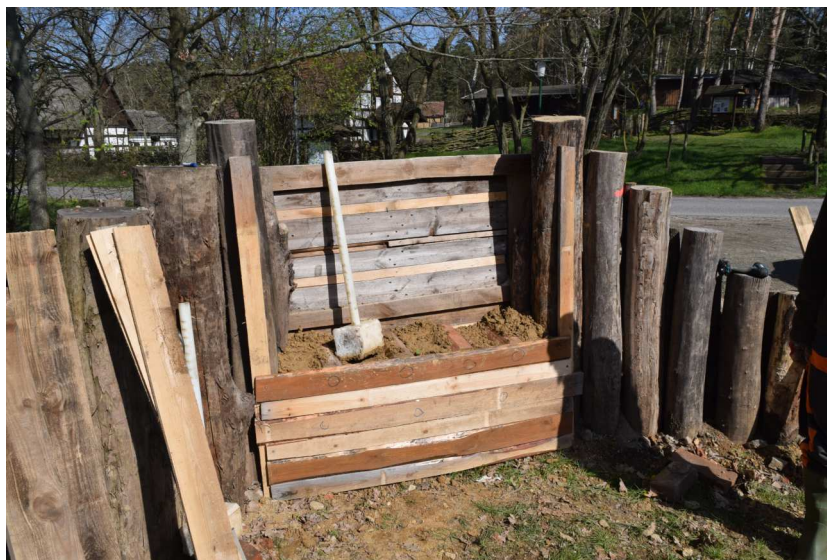
Abbildung 6: Bienenburgenbau in der Lausitz - Lehmwandbau.
