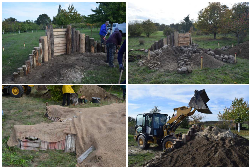
Abbildung 5: Bienenburgenbau in der Lausitz. Bauabschnitte: Setzen der Palisaden (oben links), Setzen und Abdecken des Steinkerns (oben rechts und unten links), Aufbau des Hügels (unten rechts).
