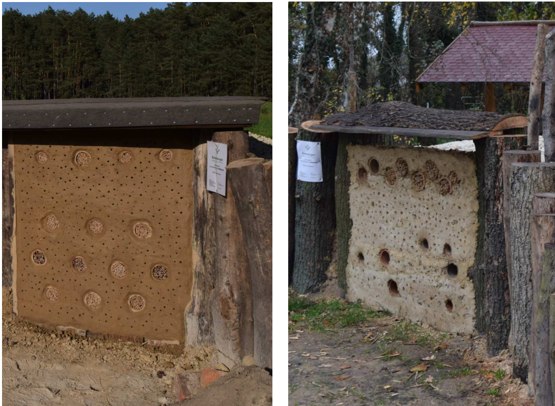
Abbildung 4: Exemplarische Darstellung der Lehmwand mit Überdachung und vorgebohrten Nistgängen, sowie Stämmen als Palisadenwände links und rechts der Lehmwand.
